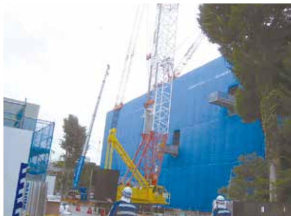
旧けやき屋敷で進む病院建築工事
